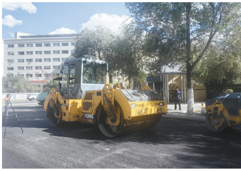
图为施工人员正在对罗堆西路施工路段开展沥青路面摊铺工作。
